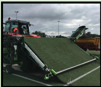
Démontage et enlèvement du remplissage
